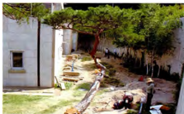
공사 전 before 자작나무 밑의 화단 작업전경
