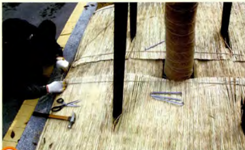
2 줄을 이용하여 피복재가 강풍이나 바람에 이동하지 않도록 끈으로 연결하여 앞가림의 고정작업을 부분적으로 한다
